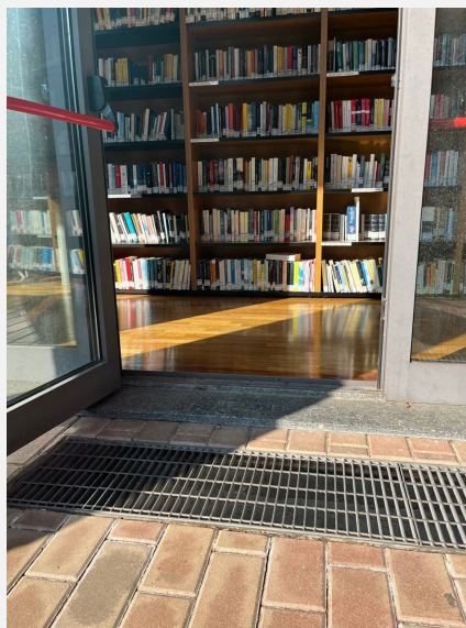
Uscita di emergenza nel lato destro della biblioteca con gradino di 3 cm sulla soglia
