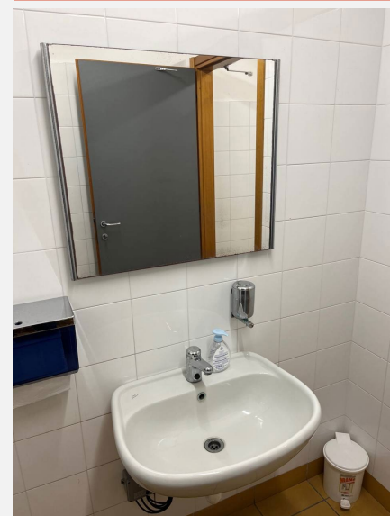
Specchio troppo alto e non utilizzabilità utenza in carrozzina
