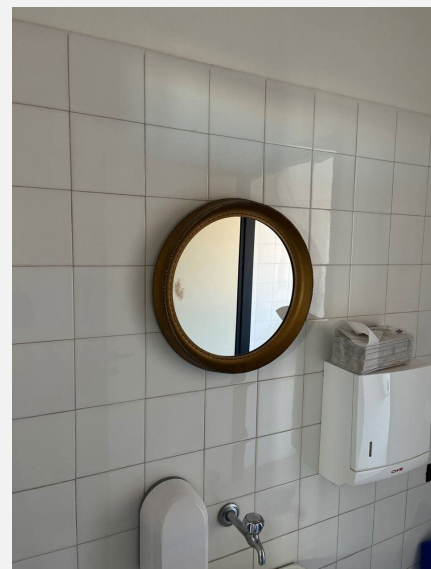
Specchio troppo alto non utilizzabile da utenza in carrozzina
