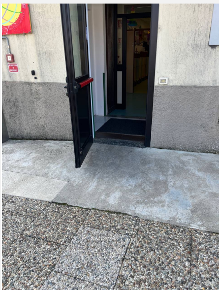
Ingresso principale reso accessibile da rampa con lieve pendenza e assenza di gradini
