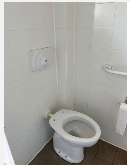
Bagno riservato all'interno dello spogliatoio maschile privo di sistema chiamata emergenza
