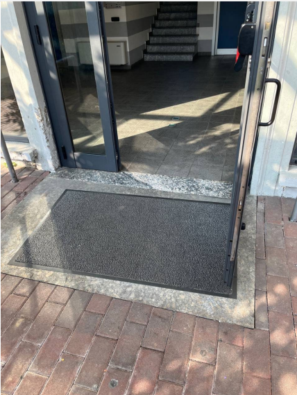
Ingresso principale reso accessibile da piccola rampa con lieve pendenza
