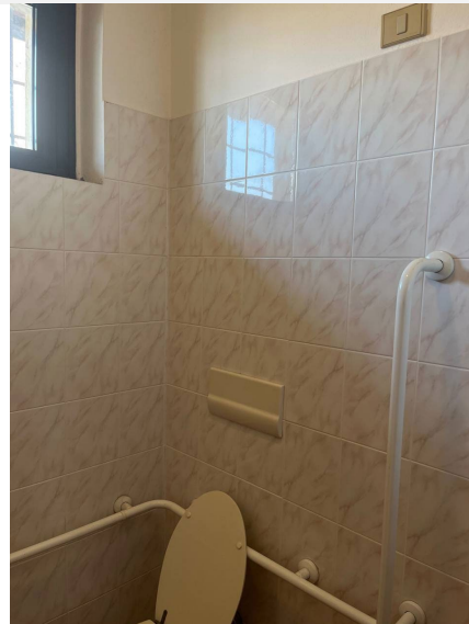
Bagno riservato a norma privo di sistema chiamata di emergenza
