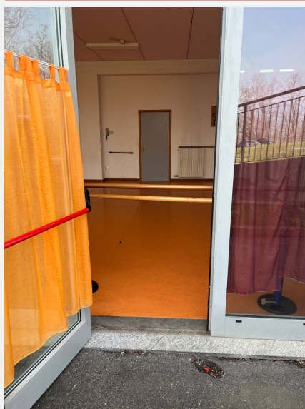
Uscita di emergenza sala danza con un dislivello di 2 cm
