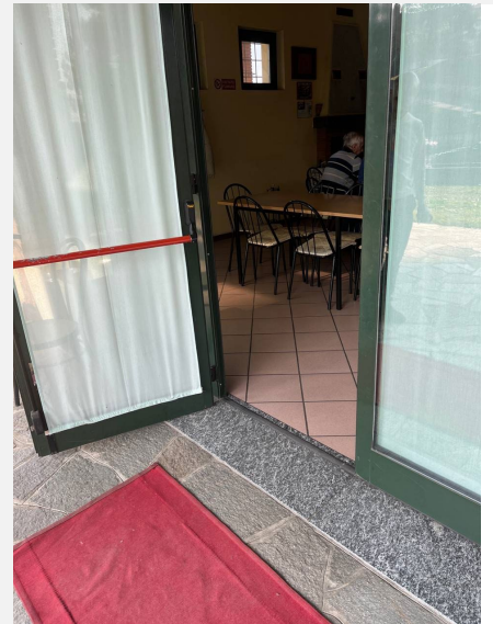
Ingresso principale accessibile privo di dislivello su soglia
