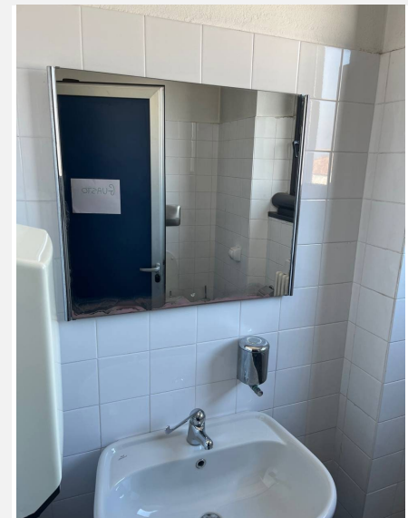
Bagno riservato primo piano con specchio ad altezza non adeguata
