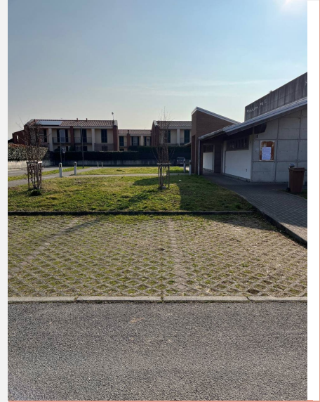
Ricollocamento dei due stalli per la sosta riservata in prossimità dell'accesso all'edificio
