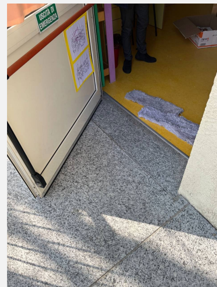
Uscita di emergenza dal lato sinistro dell'edificio privo di barriere di gradini ben raccordato con il percorso esterno
