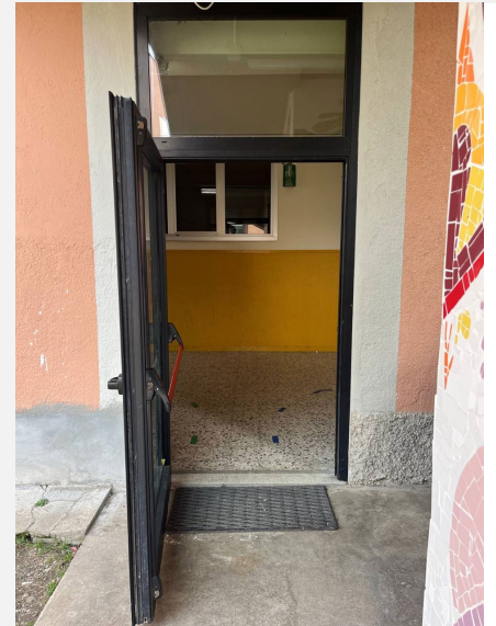
Uscita di emergenza corridoio piano terra di fronte aula Abbado accessibile
