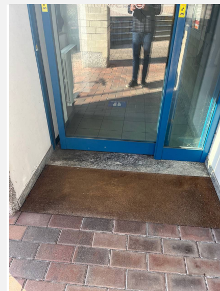
Sede del municipio con ingresso principale accessibile
