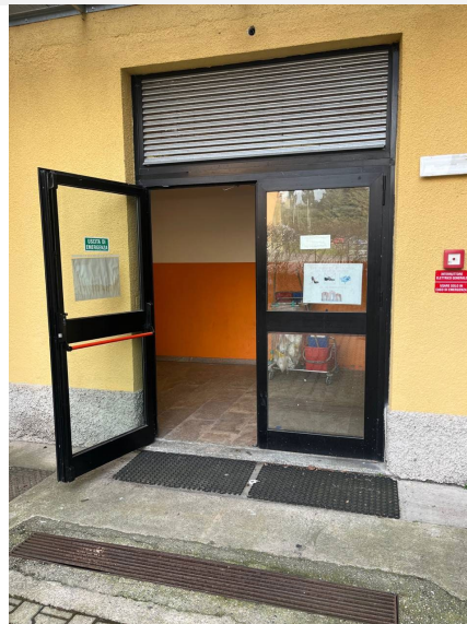
Uscita di emergenza vicina al portone antipanico della palestra non accessibile per dislivello maggiore di 3 cm
