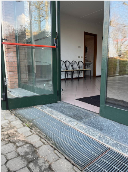
Porta di ingresso uscita posteriore direttamente dalla sala dei compleanni con dislivello di 2,5 cm
