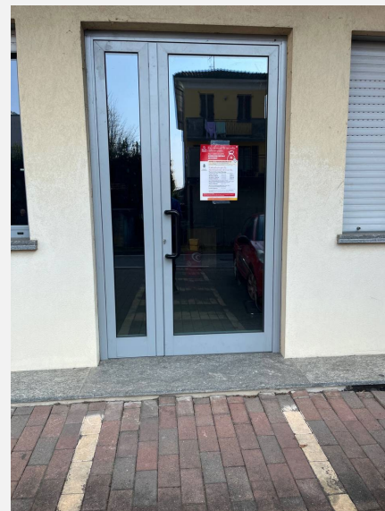
In corrispondenza di uscita emergenza sala polivalente sala riunioni del centro sociale con dislivello di 10 cm
