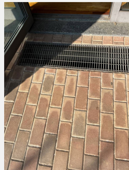
Griglia in prossimità di uscita di emergenza lato destro dell'edificio con maglia rettangolare grande
