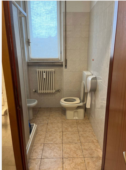
Assenza di bagno riservato. Dimensioni del bagno possono consentire l'adeguamento
