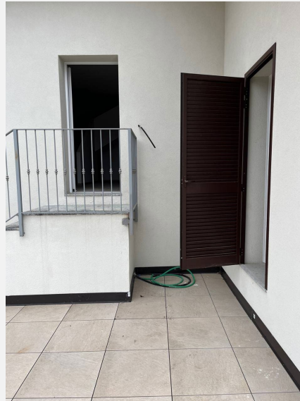
Terrazzo sul quale è presente l'accesso all'edificio accessibile sono attraverso scalinata
