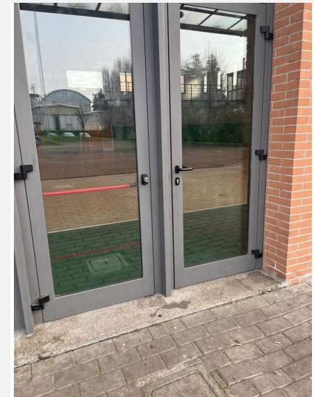
Uscite di emergenza palestra con dislivello di 4 cm
