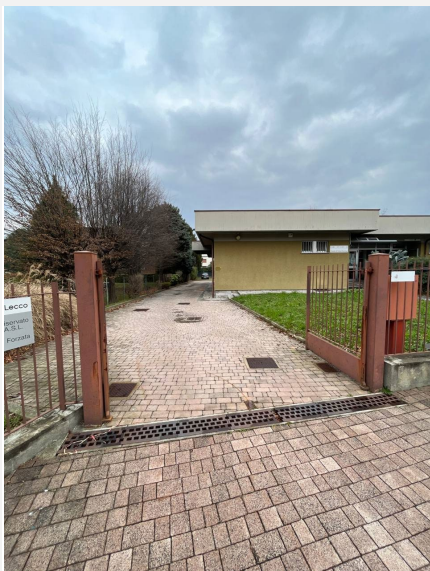
Parte esterna dell'edificio accessibile grazie alla pavimentazione in betonelle senza dislivelli
