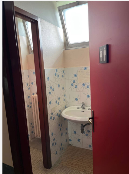
Bagno sala prelievi non dotato di accorgimenti per utenza con disabilità
