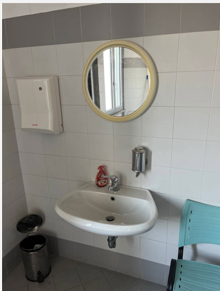
Lavandino con specchio troppo alto per essere utilizzato da utenza in carrozzina
