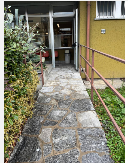
Ingresso dell'Asl accessibile grazie scalinata e rampa
