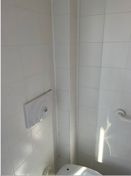
Bagno riservato all'interno del bagno maschile pubblico privo di sistema di chiamata emergenza
