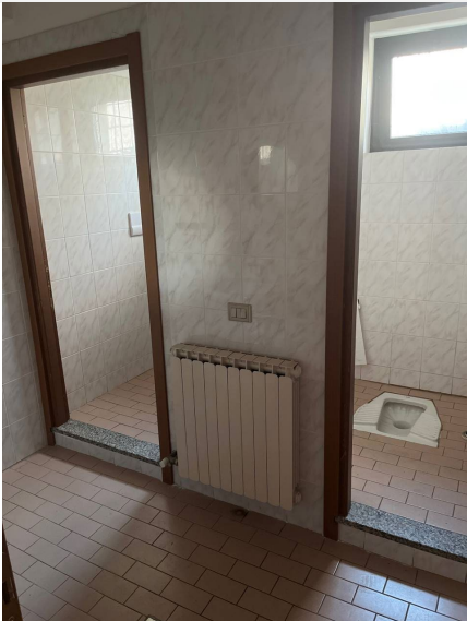
Stanza dove fanno festa di compleanno con bagno non accessibile presenza di dislivello maggiore 10 cm e privo di misure per utenza con disabilità
