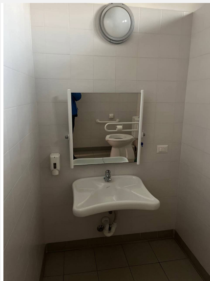
Bagno riservato all'interno degli uffici della segreteria accessibile e a Norma
