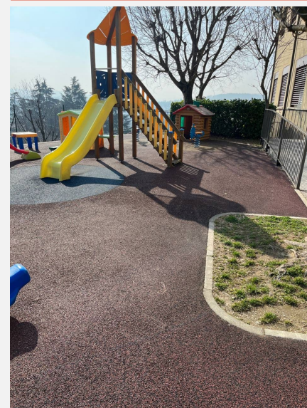
Area esterna accessibile con pavimentazione ante trauma nella quasi totalità dell'area ben raccordata con il percorso su piastrelle in ghiaia e uscita di emergenza laterale
