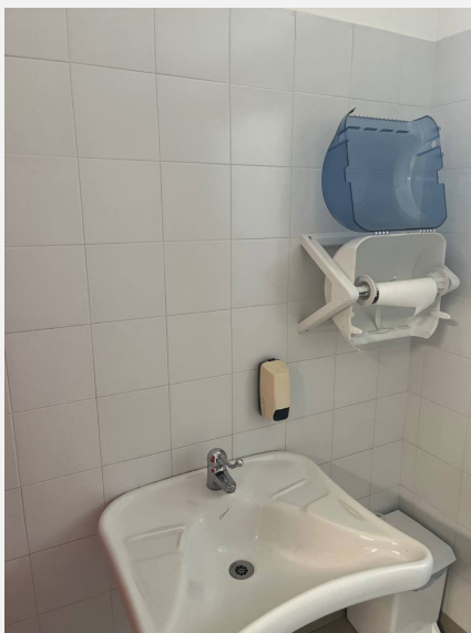
Bagno riservato primo piano via degli ippocastani con lavandino privo di specchio
