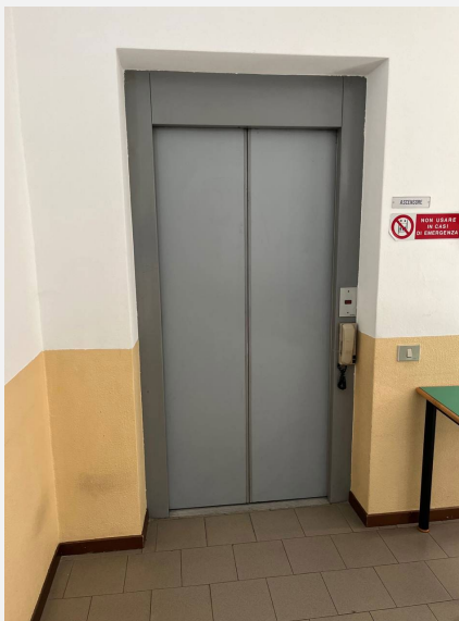
Presenza di ascensore che rende accessibili tutti i piani dell'edificio
