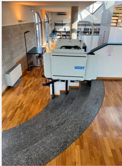
Percorso interno del primo piano reso accessibile anche con la presenza di servoscala
