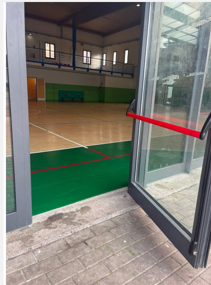
Uscite di emergenza palestra con dislivello di 4 cm
