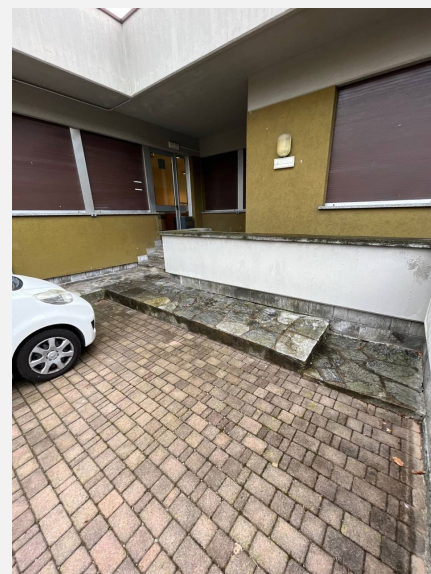
Eventuale spazio in cui fare un ulteriore ram Petra con altezza di 20 cm per accordare il marciapiede con il percorso sul parcheggio
