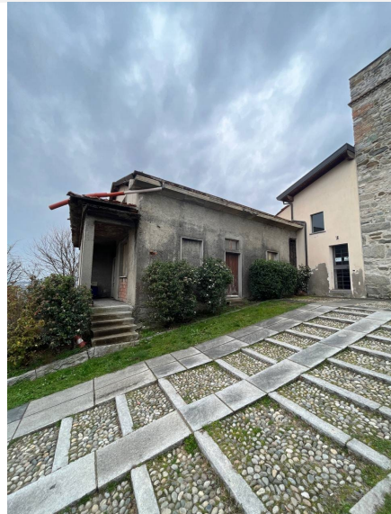
Percorso in pendenza per raggiungere la Torre Camisasca
