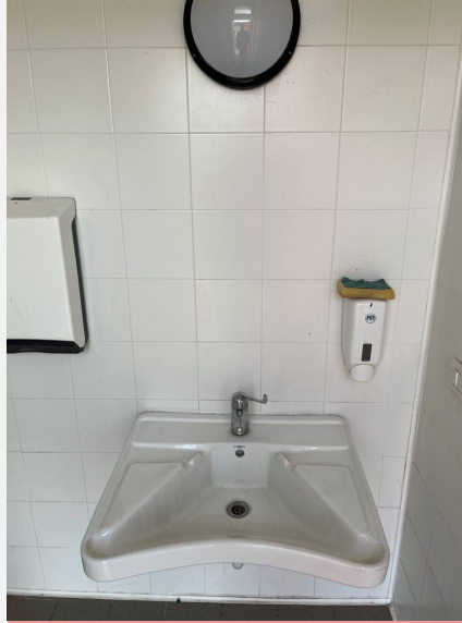
Bagno riservato all'interno del bagno maschile pubblico con lavandino privo di specchio
