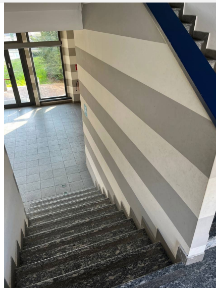
Prima rampa di scale da pianoterra pianerottolo prima del primo piano privo di corrimano
